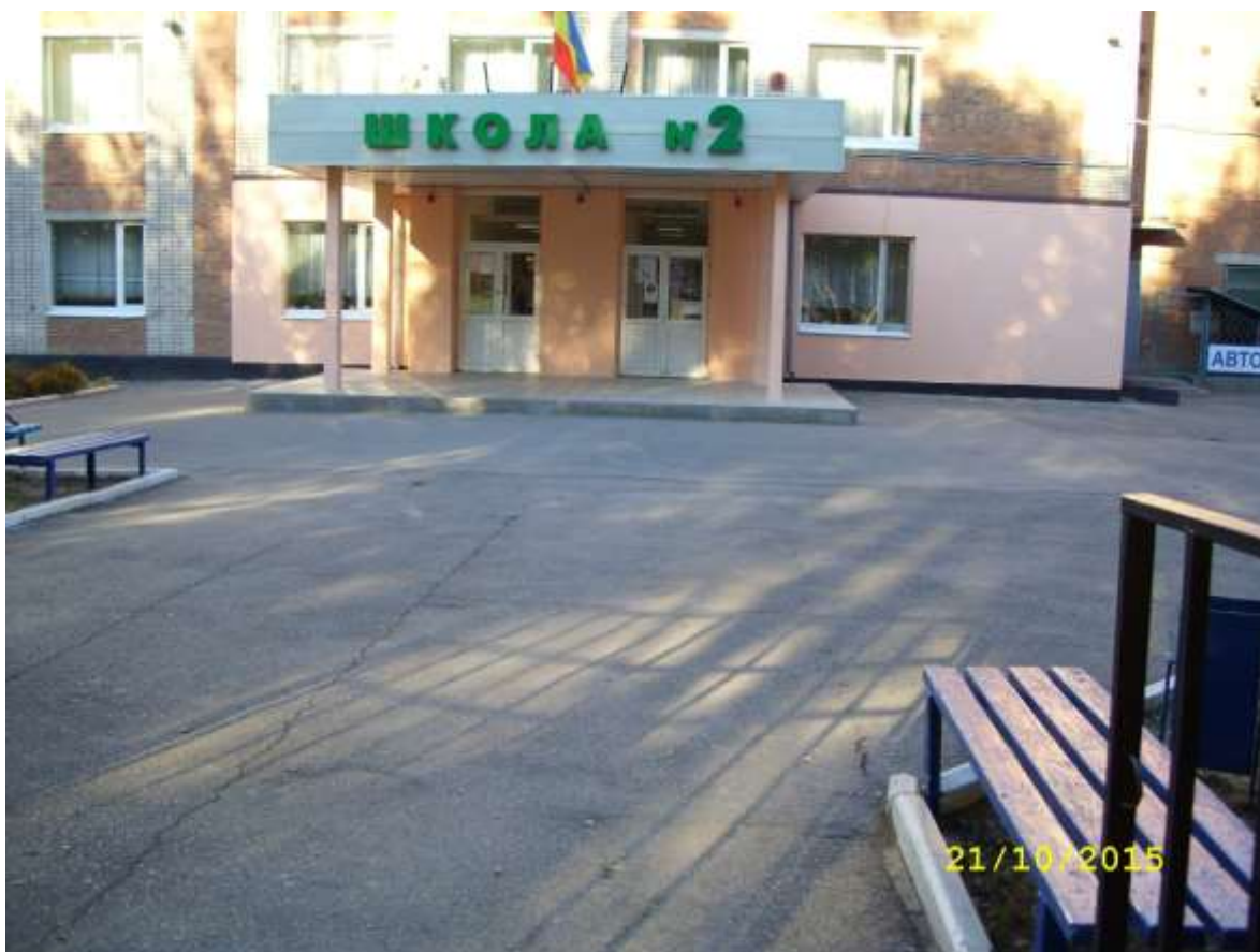
Фото № 7. Подход к центральному входу
