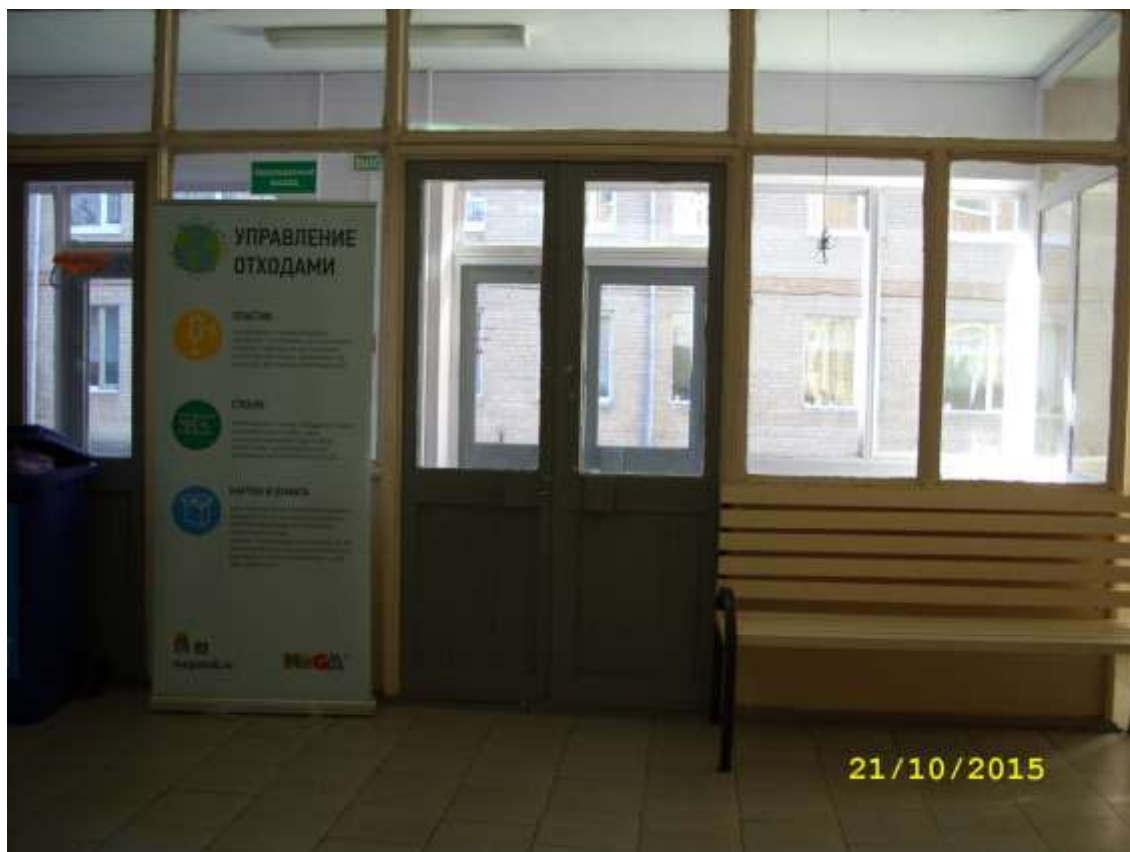
Фото № 22. Эвакуационный выход, вид изнутри здания
