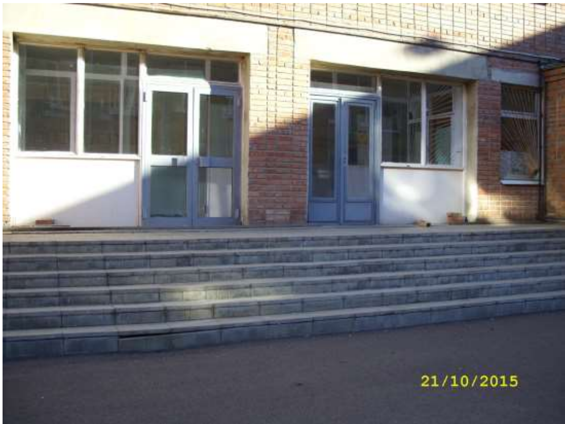
Фото № 23. Эвакуационный выход, вид снаружи здания
